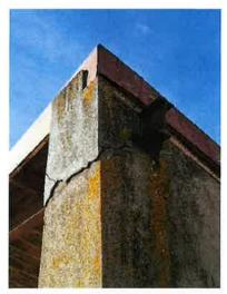
La maçonnerie sera entièrement nettoyée au jet haute pression. Un toilage des parties crépies sera encollé avant l'application d'une couche d'accrochage, suivie d'une finition à l'ancienne en chauxciment, tirée à la truelle, afin de lui redonner son aspect d'antan.
